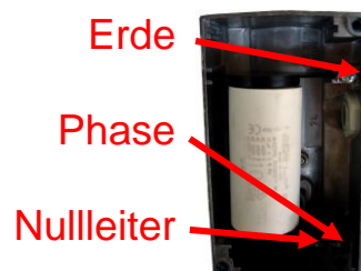
Verkabelung des 230V Pumpkastens
