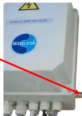
Verkabelung des 400V Pumpkastens
