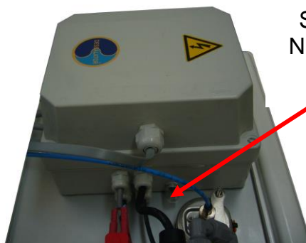
Verkabelung des 230V Pumpkastens
