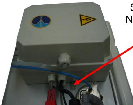
Sicherung für die Niederdruckpumpe
