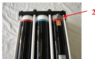
*Conseil : Sur les membranes, afin de faciliter l'orientation des connexions sur les raccords inox haute pression<sup>2</sup>, il est possible de tourner les têtes à 90°. Pour cela, dévisser les embouts gris de production. Enlever ensuite les caches écrous et desserrer les 12 écrous maintenant l'ensemble. Enlever le tirant gênant et tourner la tête de membrane à l'aide d'une clé à pipe emboîtée dans l'embout inox. Replacer le tirant et resserrer l'ensemble.*
