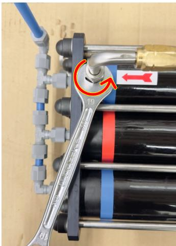
Avec une clé plate n°19, dévissez les raccords des 2 tuyaux haute pression.
